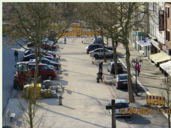
kurz vor Fertigstellung
