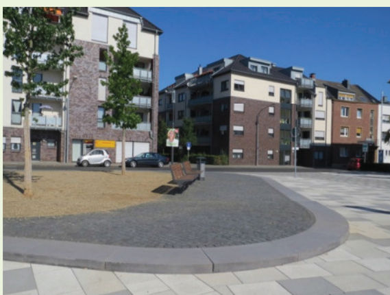
Neue „Bauminsel“ – Blick nach Norden
