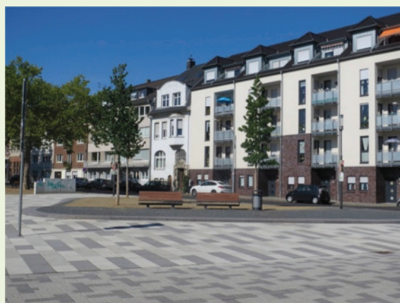
Vorfläche Festhalle – Blick auf neue „Bauminsel“
