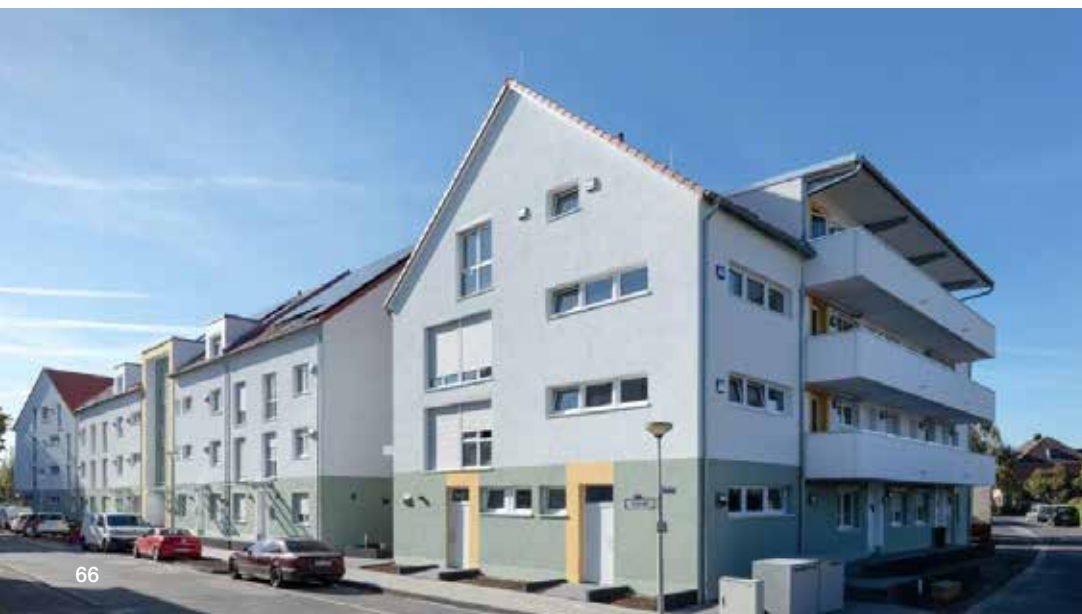
„Klimaschutzsiedlung“ Oststraße, Viersen
