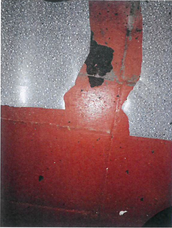
Foto 45: Gussasphalfliesen im EG des Kutscherhauses (P 34)
