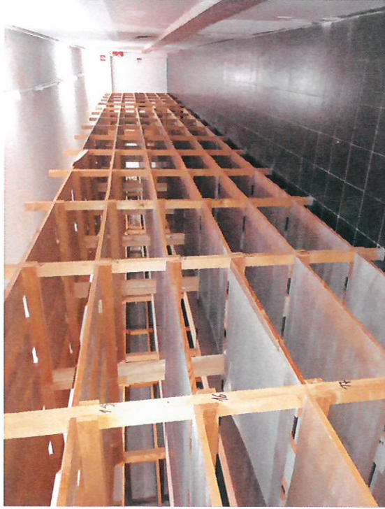
Foto 39: Lagerraum im 1. OG der Villa mit Gussasphalfliesen
