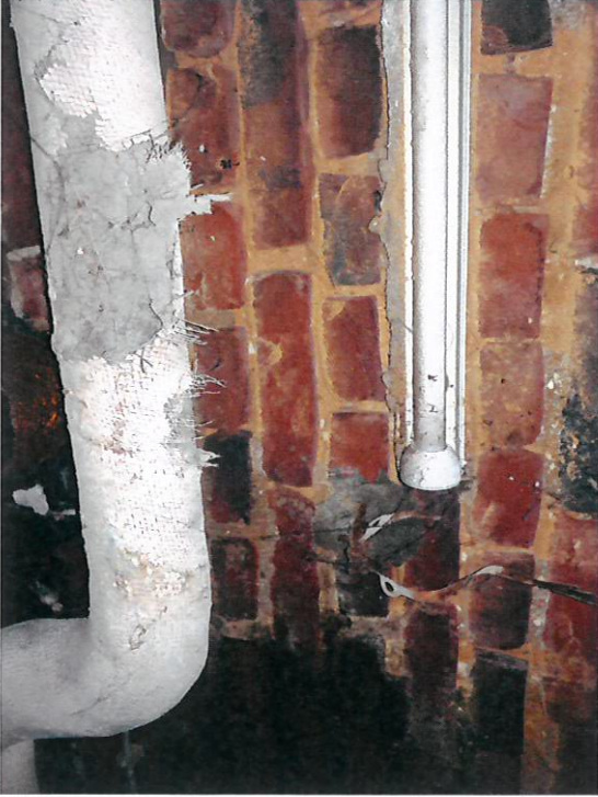
Foto 33: Rohrleitung mit Gipsmantel (P 24)
