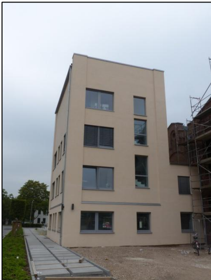
Bereits sanierter und genutzter Turm im Süden der Papierfabrik
