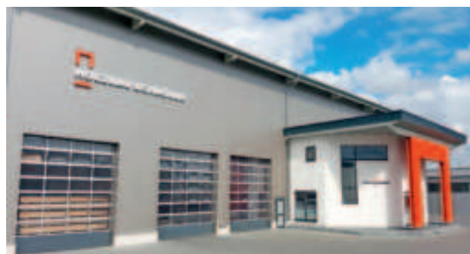
Die Produktionshalle von Holzbau Schröder in Niederkrüchten.
