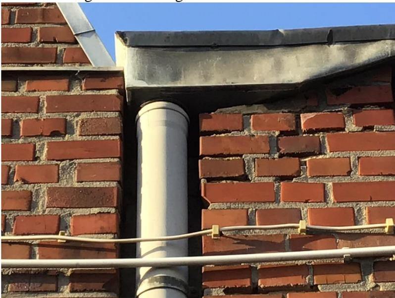
Abb. 4: Verkleidung der Dachentwässerung mit Lücken
