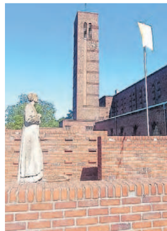
Die Pfarrkirche St. Notburga mit dem charakteristischen Turm besitzt ein langgestrecktes, rechteckiges Mittelschiff mit auffallend niedrigen Seitenschiffen und einem flachen, eckigen Chorabschluss. Foto: Stadt
